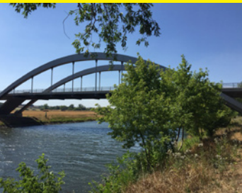
Brücke über die Saale bei St. Georg.
