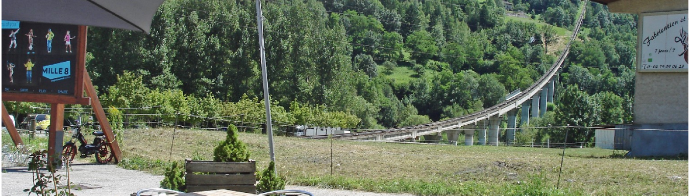
Standseilbahn: Bourg St. Maurice – Arc 1600 , Länge 2.885km, Steigung 0 bis 39%, Höhendifferenz: 818m, Baujahr 1989
